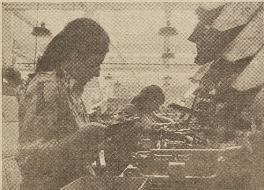
Marta Prunk vlaga elemente na tiskano šasijo za radijske sprejemnike.
