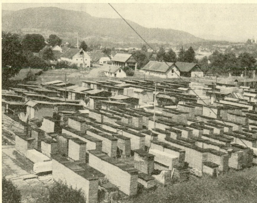
Skladišče v PE Verd preko katerega bo zgrajen viadukt nove hitre avtomobilske ceste
