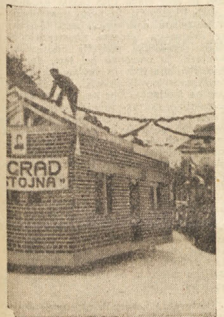
Delavci okrajnega gradbenega podjetja »ZIDGRAD« v Postojni bodo zidali mnogo novih hiš
