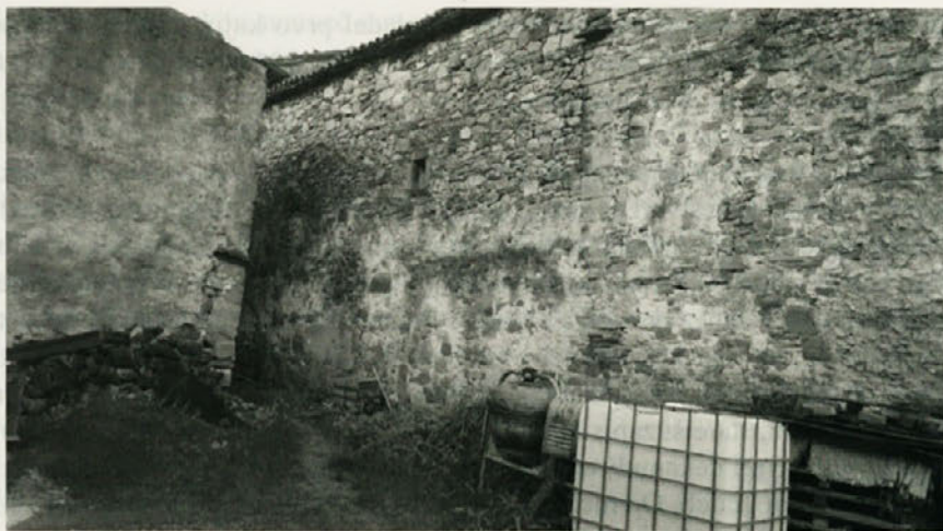
Ruševine nekdanje hišne št. 59, iz katere izhaja Janez Mercina. V začetku 70. let je stavba še stala.
