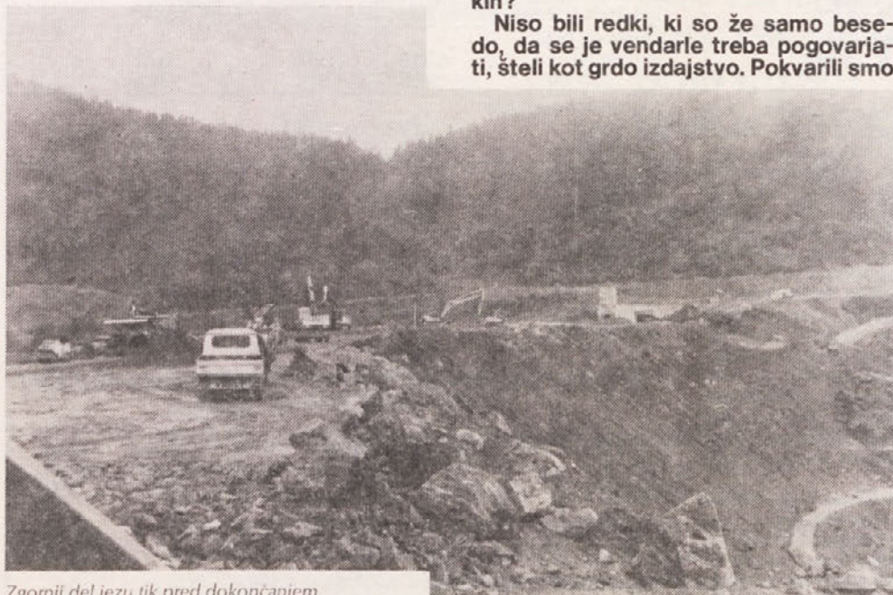
Zgornji del jezusa tik pred dokončanjem
