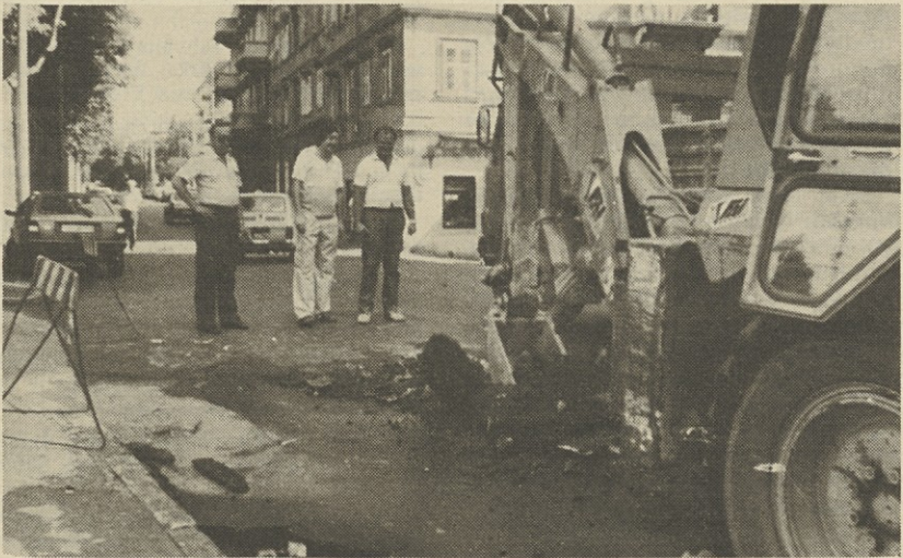
Dela za popravilo okvare na vodovodnem omrežju so hitro stekla
