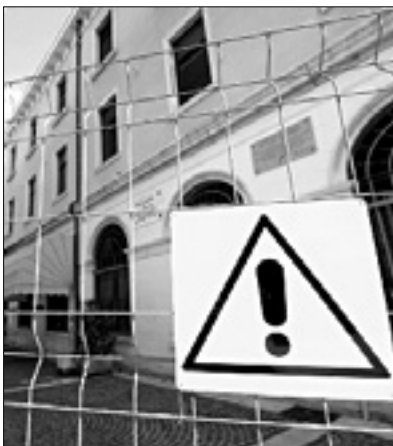
Ograjena občinska stavba
