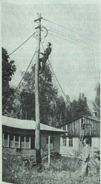
Električni kabel do stare ambulante je že napeljan, sedaj pa so na vrsti drugi
