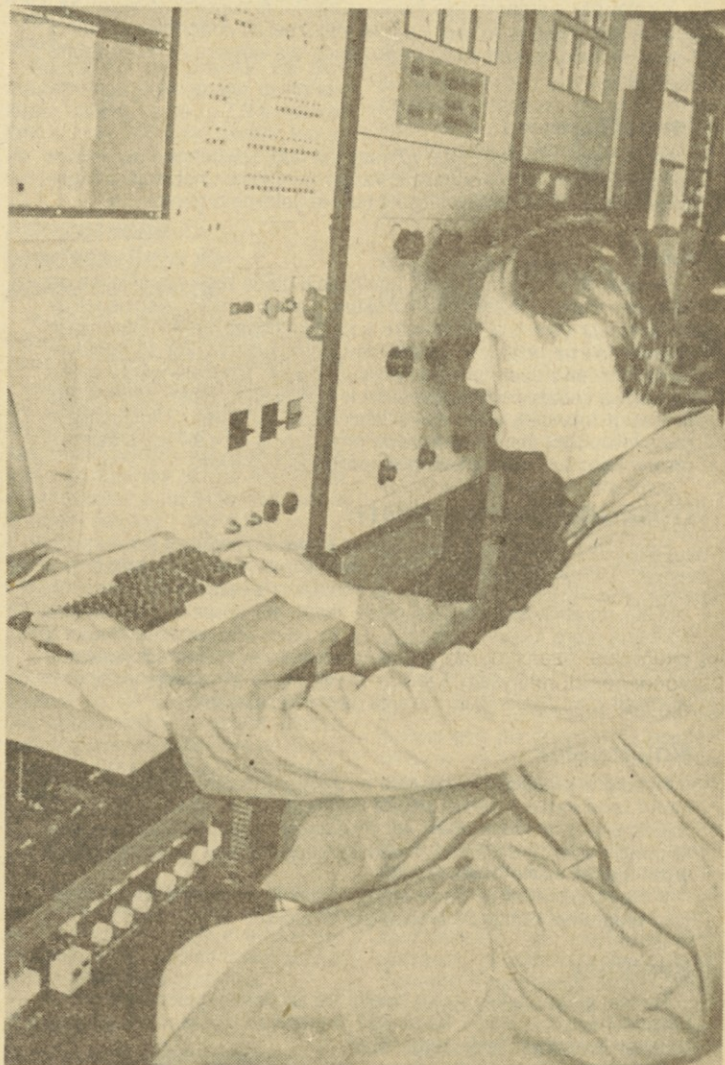
Strokovnjaki TOZD Inženiring so pri zasnovi novih naprav upoštevali najnovejša spoznanja elektronike in procesnega računalništva — Foto: Ivan Okršlar
