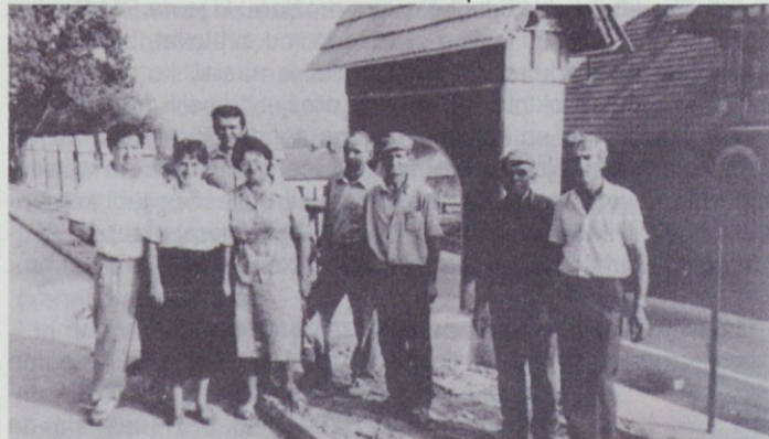
Izvajalci pri obnovi šolske ograje pred vhodnim portalom 1989
