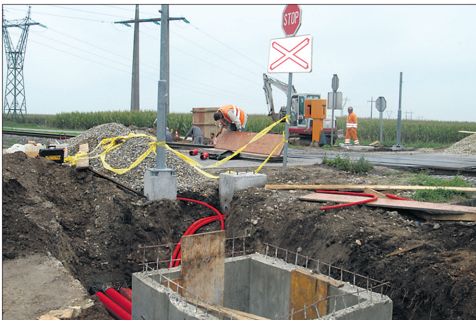
Delavci Slovenskih železnic ter podjetij PAP Mobil in Siemens so včeraj kljub občasnim padavinam nadaljevali z gradbenimi deli za postavitev zapornic.
