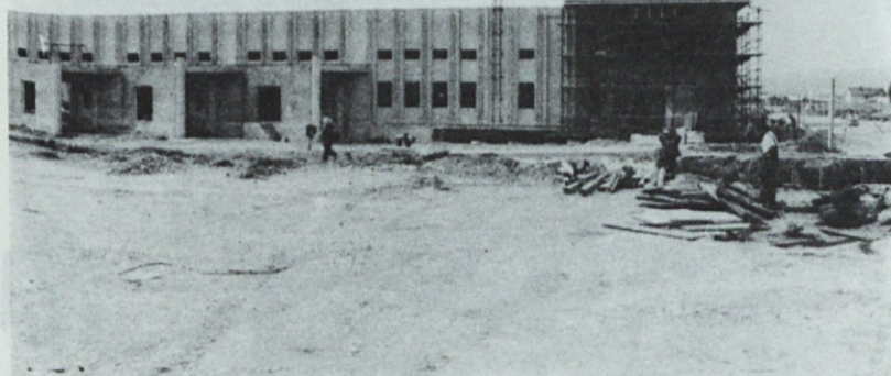
Pogled na novo tovarno z Letališke ceste (levo nakladalne rampe).
