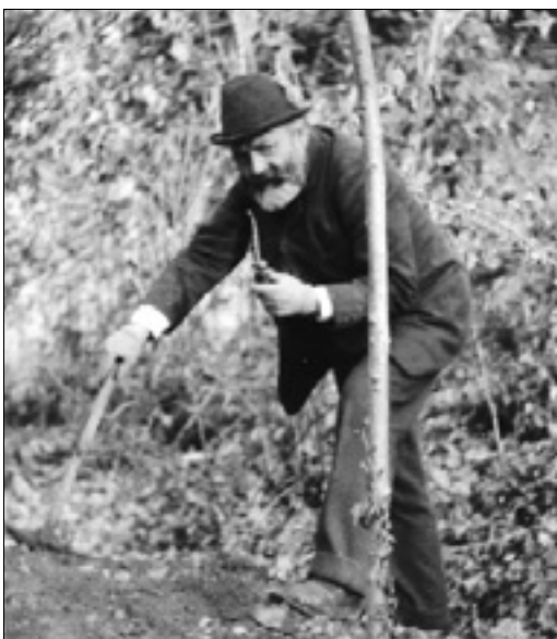
Redka fotografija L. K. Moserja pri izkopavanju
