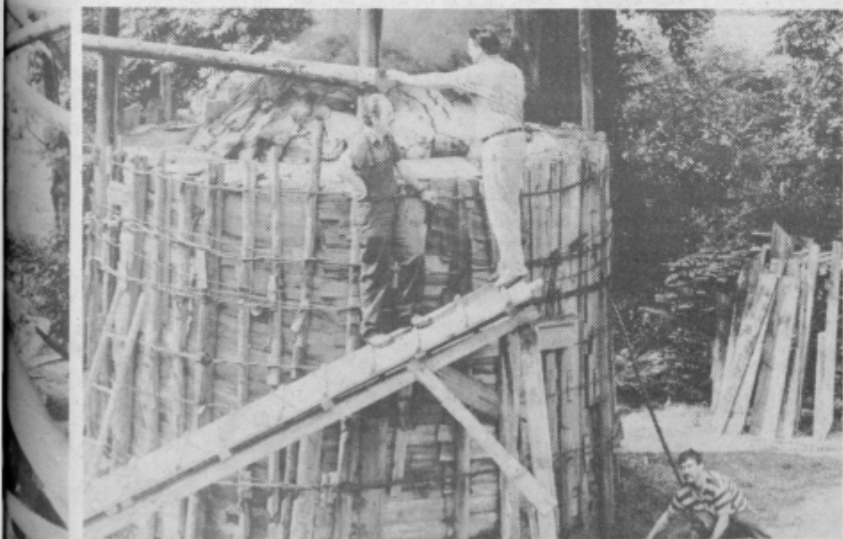
Apnenico je treba dobro pripraviti, kajti apno se kuha sto ur. Atelškova apnenica pa je stara že dobrih 60 let, saj sta pred njim to delo opravljala stari oče in oče.
