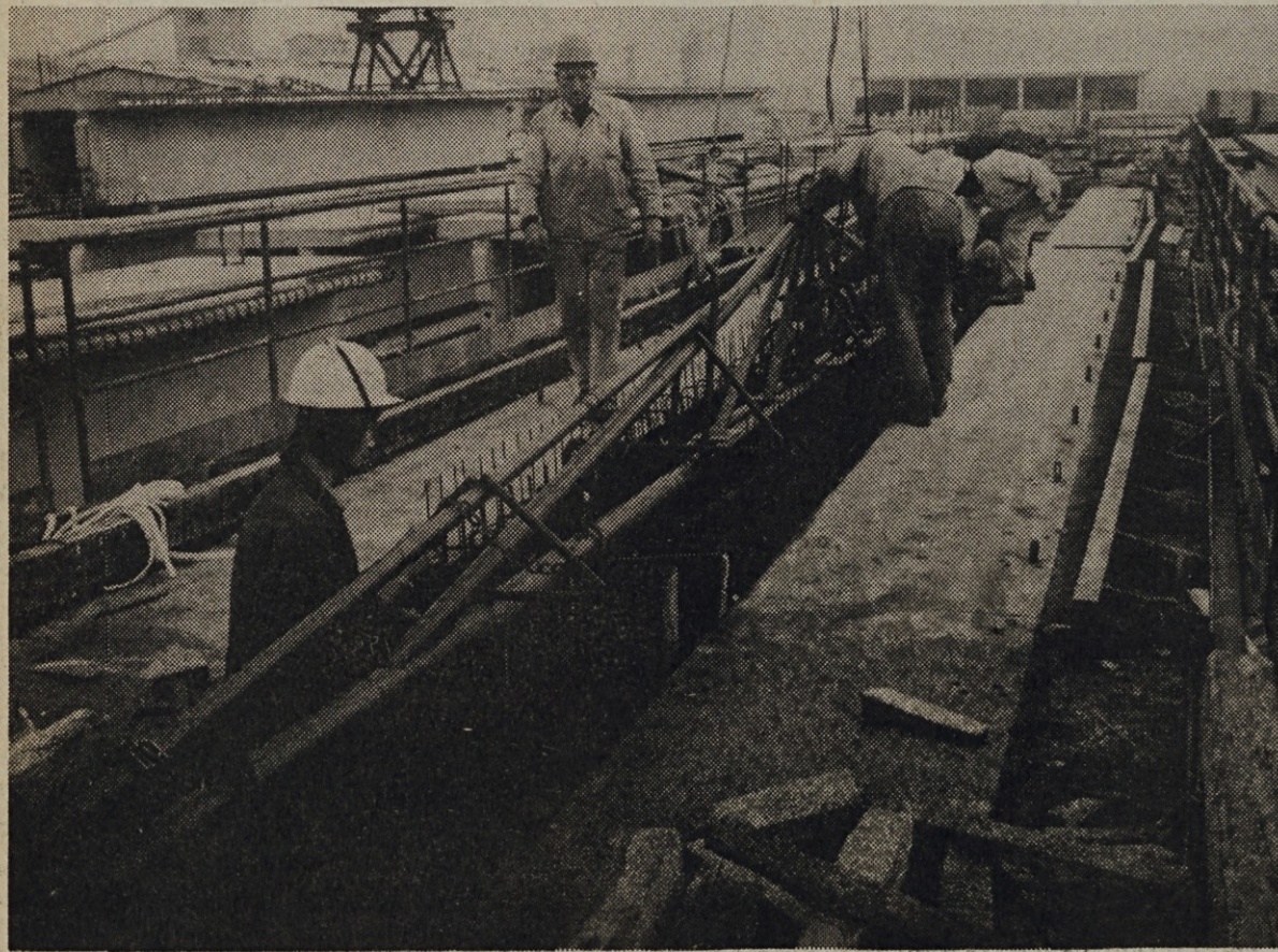
Čeprav so naši delavci na še tako oddaljenem gradbišču, jim je potrebno omogočiti pravilno obveščanje in odločanje o zadevah
