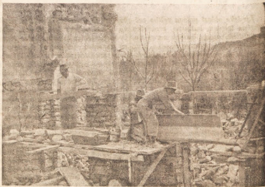
Obnova porušenih hiš na Cesti pri Ajdovščini
