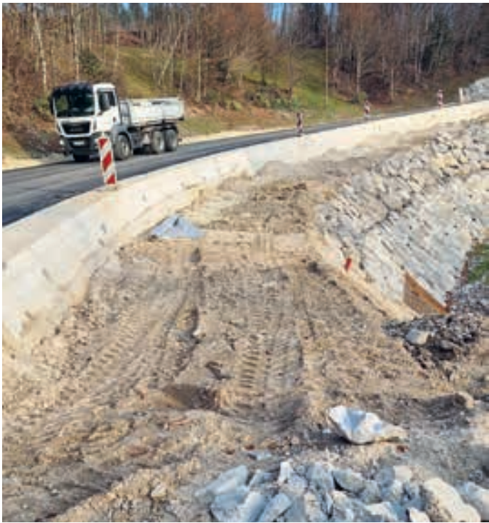
Asfaltiranje na območju sanacije plazu Zalog
