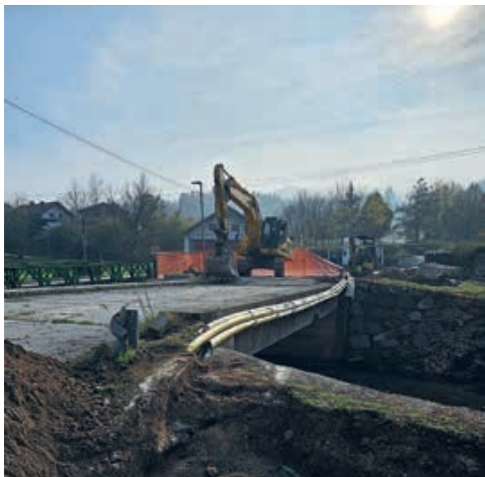
Rušenje starega mostu Hruševo
