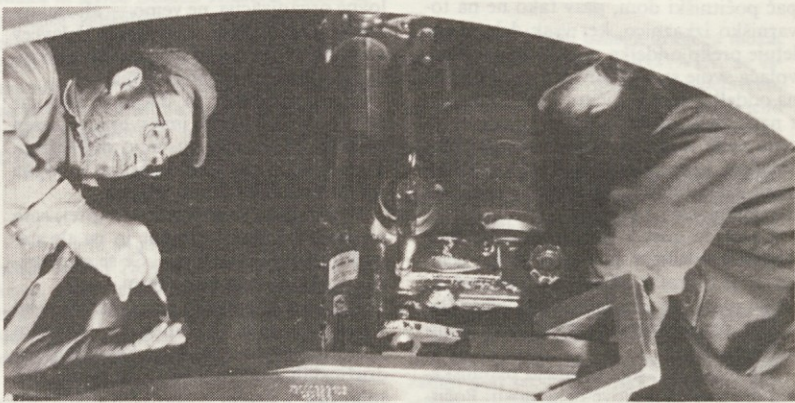
Struženje izvrtin na turbinski gredi med montažo na HE Stratos (Foto: Grosman)
