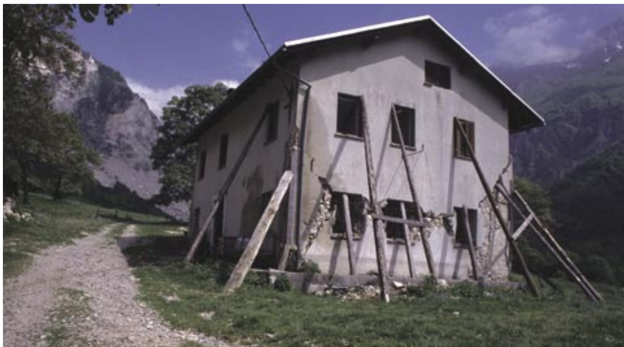
Slika 2: Zaradi potresa močno poškodovano sirarno na planini Polog so kasneje v celoti porušiti in zgradili nadomestno (foto: Miha Pavšek).
