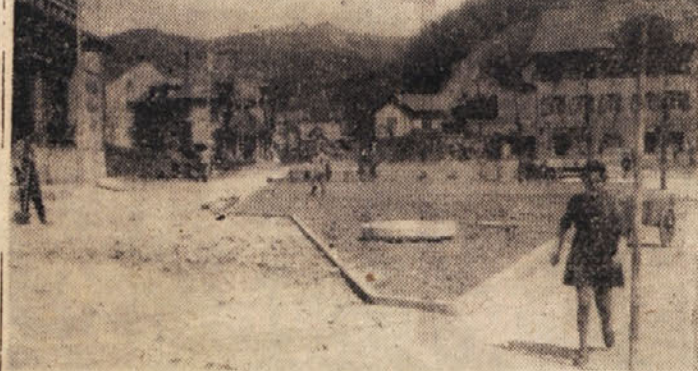
Delavci trboveljske Komune končujejo te dni z deli pri ureditvi parka pred poslopjem NB, s čimer bodo Trbovlje precej pridobile na lepši podobi. Dela so bila urejena s sredstvi občinskega LO in delno tudi NB
