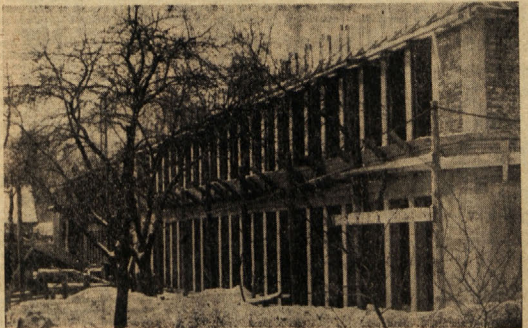
Gradnja nove bolnišnice v Trbovljah
