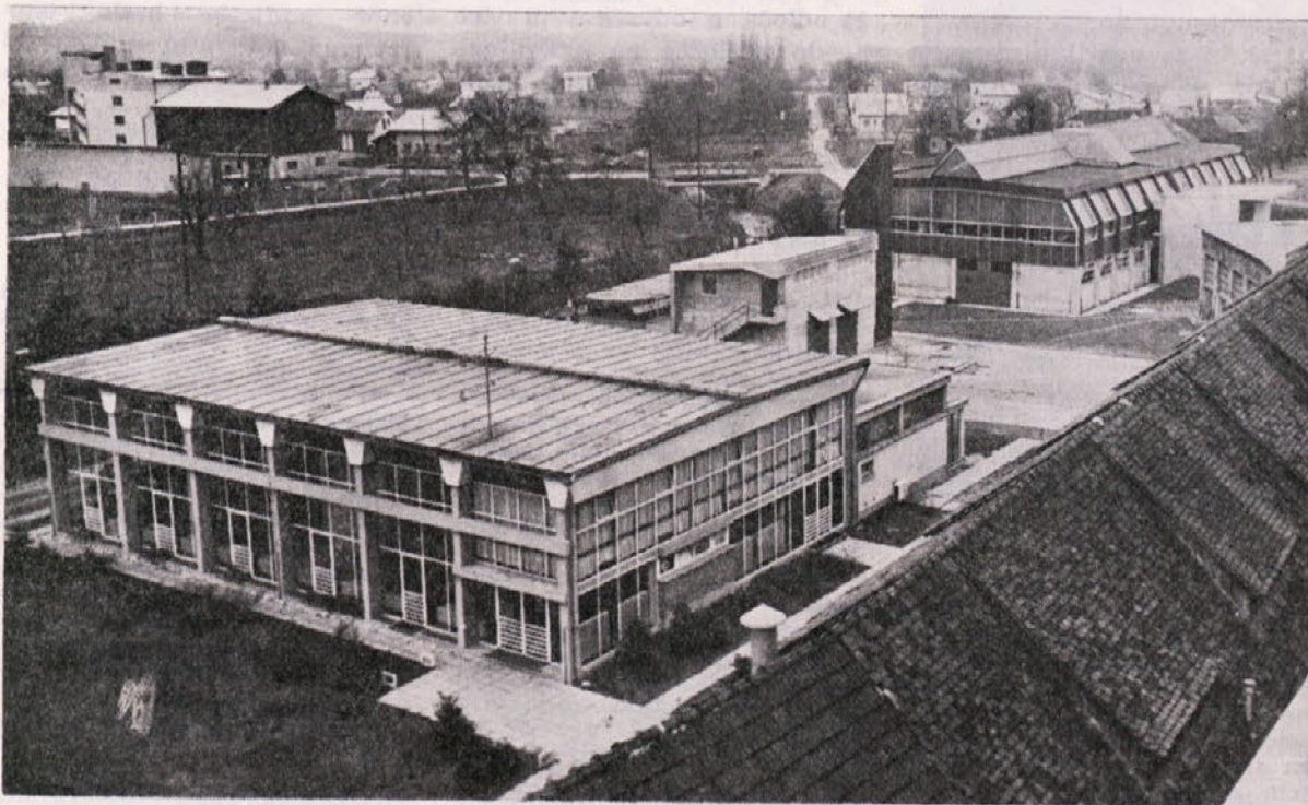
Kompleks objektov, ki smo jih v zadnjem času zgradili za Konus in Sicer: jedilnica, gasilski dom in Koko.
