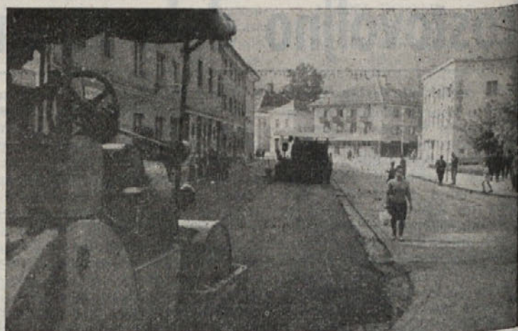
KOČEVJE PRED PRAZNIKOM — Vse hiti in se pripravlja na veliki jubilej — 20-letnico Kočevskega zbora. Mesto mora biti tedaj lepo, prerojeno, da bo dostojno pričakalo tisoče gostov. — Na sliki: asfaltiranje parkirnih prostorov pred lekarno.
