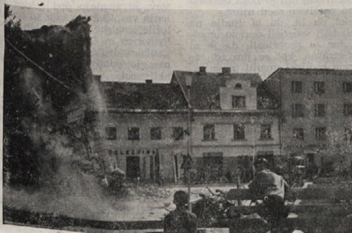
Sajevčeve hiše ni več in zdaj bo kmalu urejeno tudi nevarno križišče, na katerem se je zgodilo že več prometnih nesreč. (Na sliki: Se malo in še en zid Sajevčeve hiše bo padel.)
