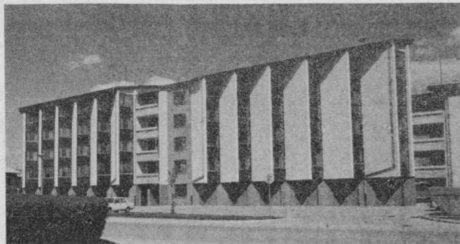
Druga faza samskega doma na Hudinji za potrebe delavcev. Gradis je ob razvoju temeljne organizacije vedno skrbel tudi za standard delavcev. 750 zaposlenih ima zagotovljena stanovanja v zidanih samskih domovih – dveh v Celju in enem v Velenju.
