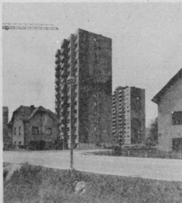
Stolpnici ST 7 in ST 8 v Novi vasi sta že vseljeni, v izgradnji pa je stolpnica ST 9, ki bo vseljiva prihodnje leto.
