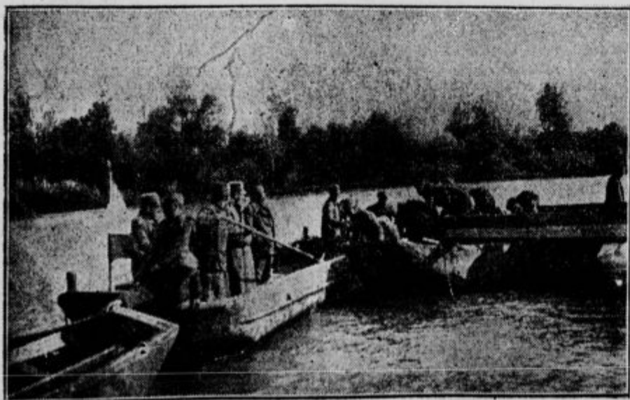
Motorni vlačilec prevaja sestavne dele pontonskega mostu.
