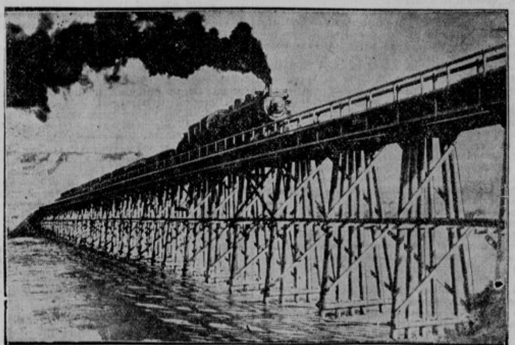
Največji nasip na svetu grade v Arizoni v Sev. Ameriki. Delajo noč in dan. Kako ogromen bo nasip, vidimo po zasilnem mostu na sliki.
