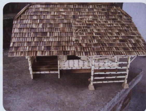
Streha je iz skodel, obžganih z gorilnikom
