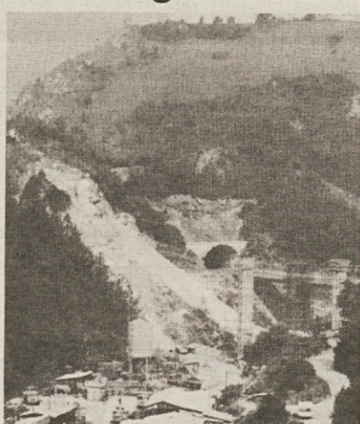
Pogled na gradbišče transjugoslovanske ali "evropske avtoceste" v neposredni bližini Sarajeva.
