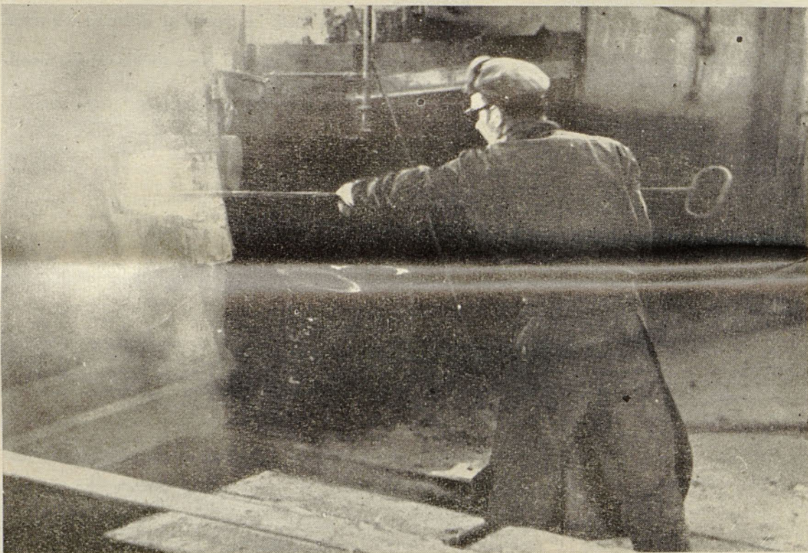
Kontrola raztaljene sive litine v obločni peči pred zalivanjem katodnih blokov
