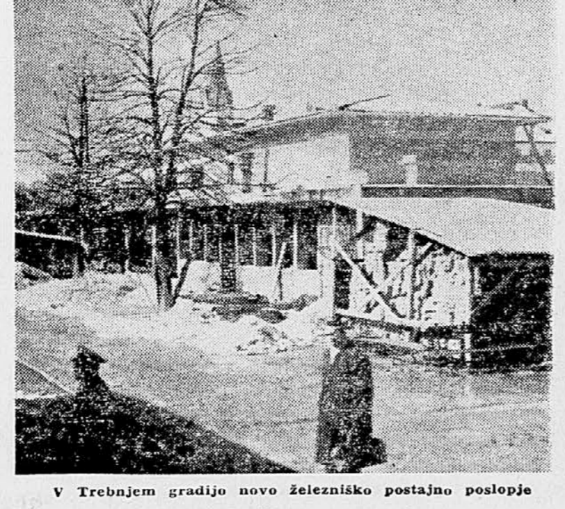
V Trebnjem gradijo novo železniško postajno poslopje
