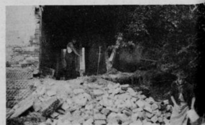
Na vzhodni strani gospodarskega poslopja je zazijala velika luknja
