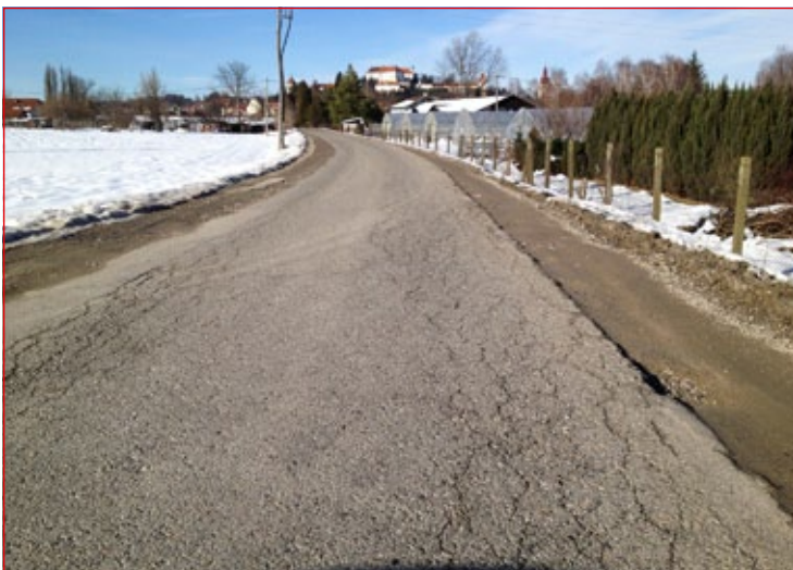
Letos se bo po besedah predsednika ČS Breg Turnišče zgodila razširitev ceste s kolesarsko stezo od križišča pri Puhovem mostu (mimo Semenarne) do Zadružnega trga.
