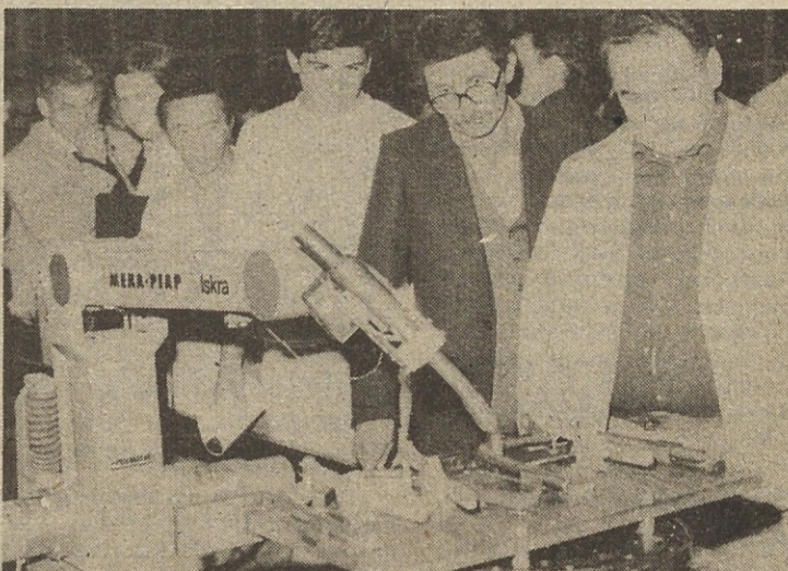
V okviru prve jugoslovanske razstave robotizacije je Avtomatika razstavila varilni robot z zasušnim manipulatorjem z orbitalno mizo.
