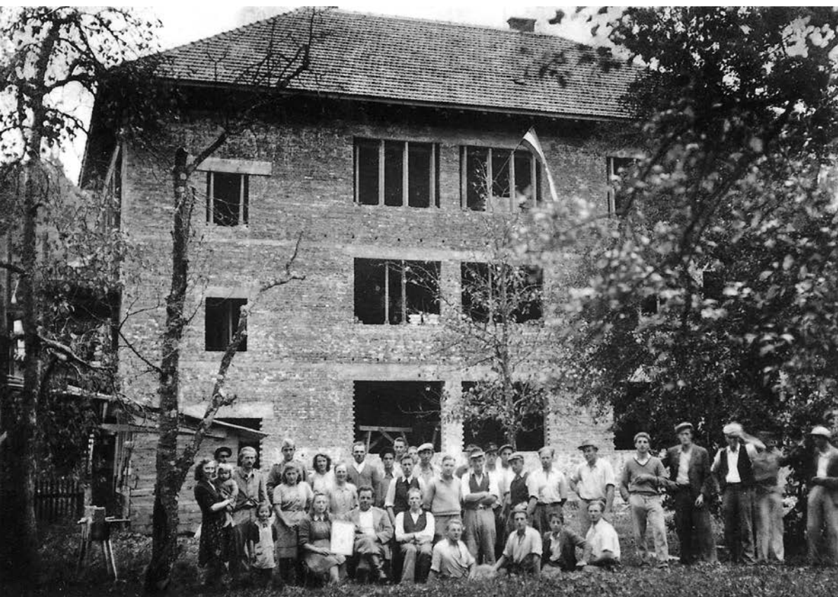
Gradnja nove šole v Osilnici 1951 (arhiv: Cveto Vesel, Sela)
