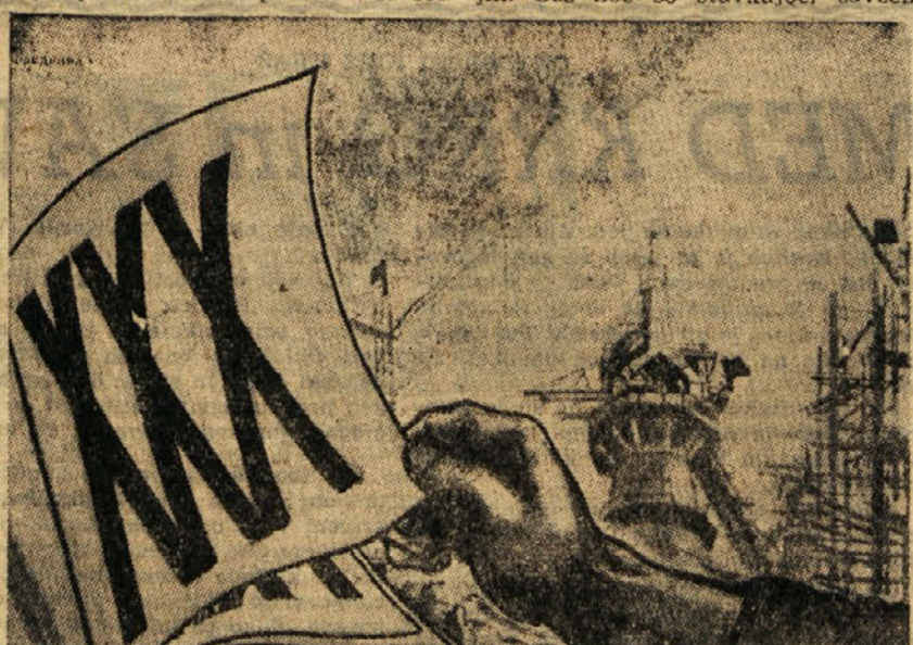
Začelo se je novo desetletje.
