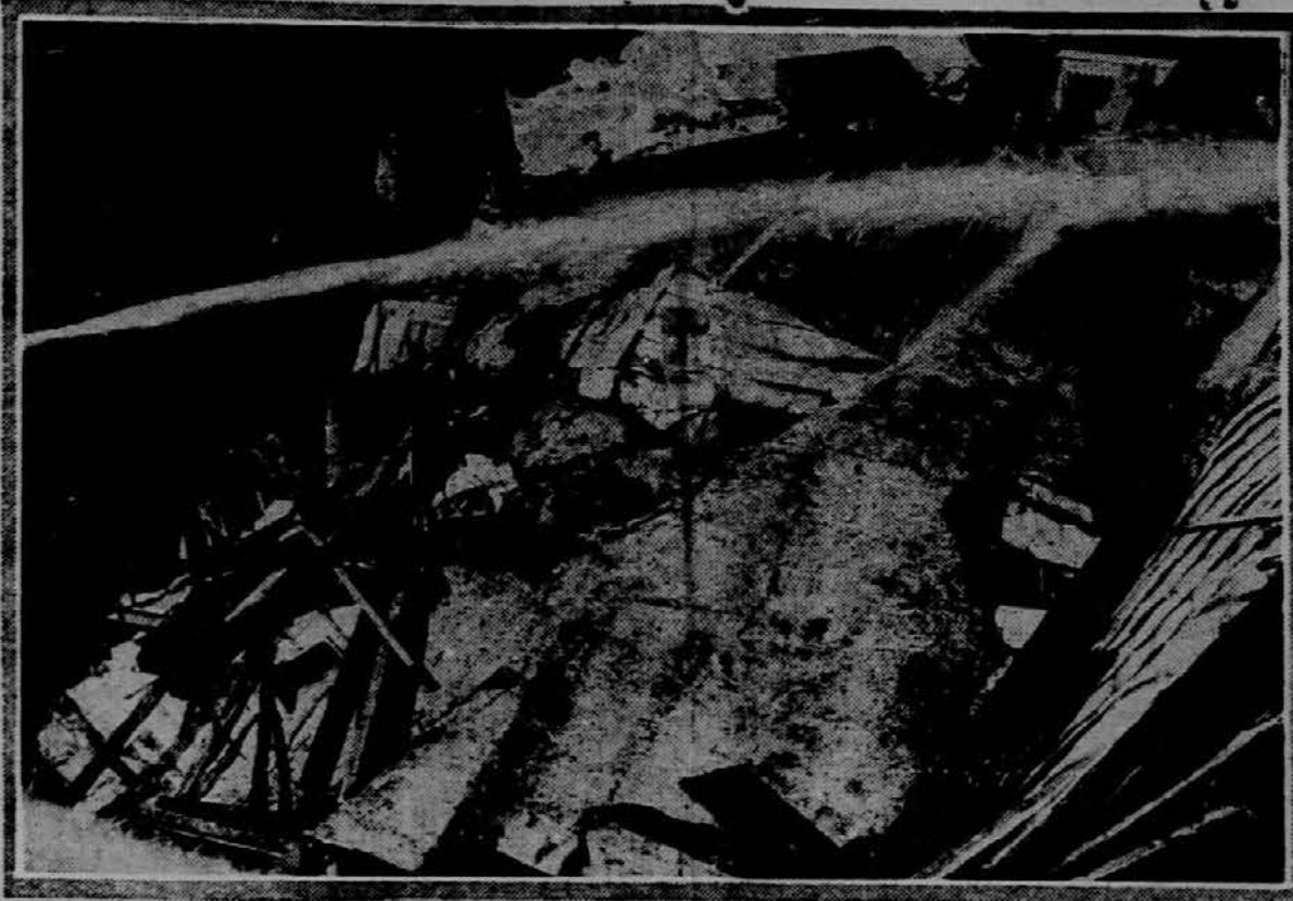
Pred kratkim je izbruhnil v nekem brooklynskem plešišču požar, ki je zahteval dve človeški žrtvi. Mrtva sta bila dva og njegeasa, enajst jih je bilo pa težko poškodovanih. Slika nam kaže del notranjštine poruše nega poslopja.
