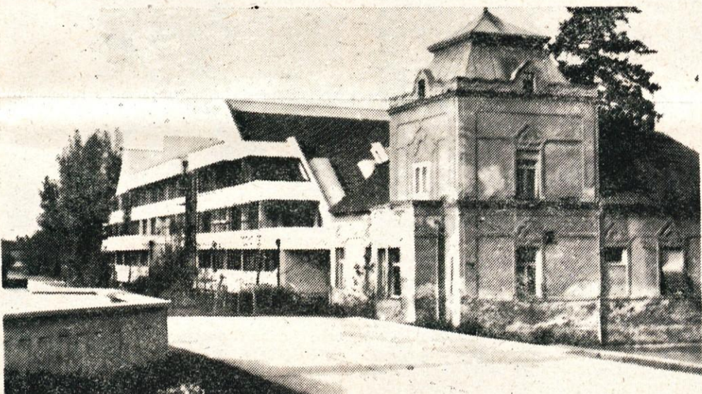
OPŠTINA NOVI BEČEJ TAKOĐER JE ZBRATIMLJENA S KOPRIVNICOM
