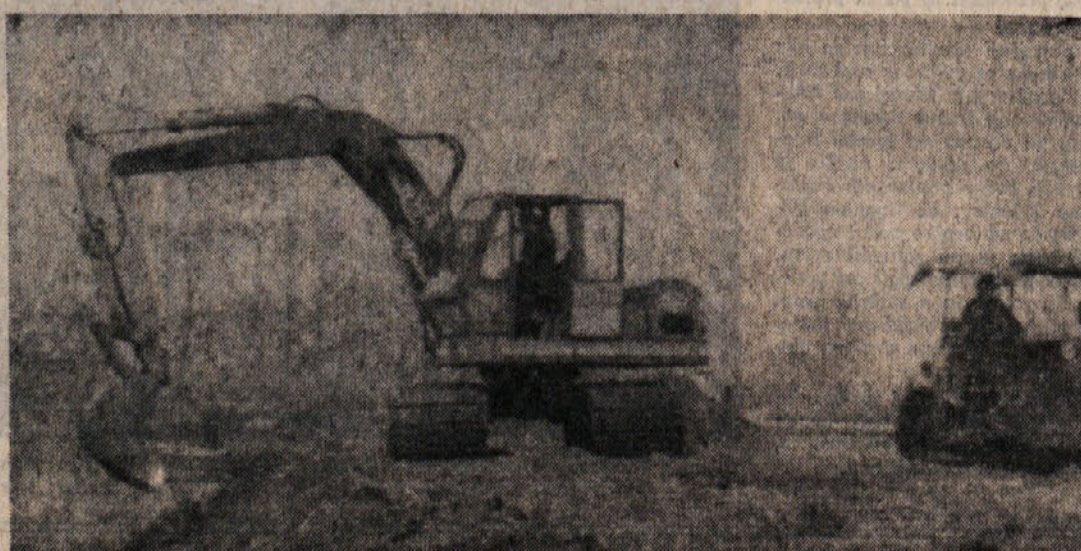
Te dni se je pričela gradnja avtocestnega odseka Ljubljana-Vrhnika. Prvi del odseka (11,4 km) bo stal 639 milijonov dinarjev. Doslej so na trasi avtoceste »Slovenika« že zgradili in odprli prometni odsek Razdrto-Vrhnika med Trstom in Ljubljano ter nekaj odsekov v smeri proti Mariboru
