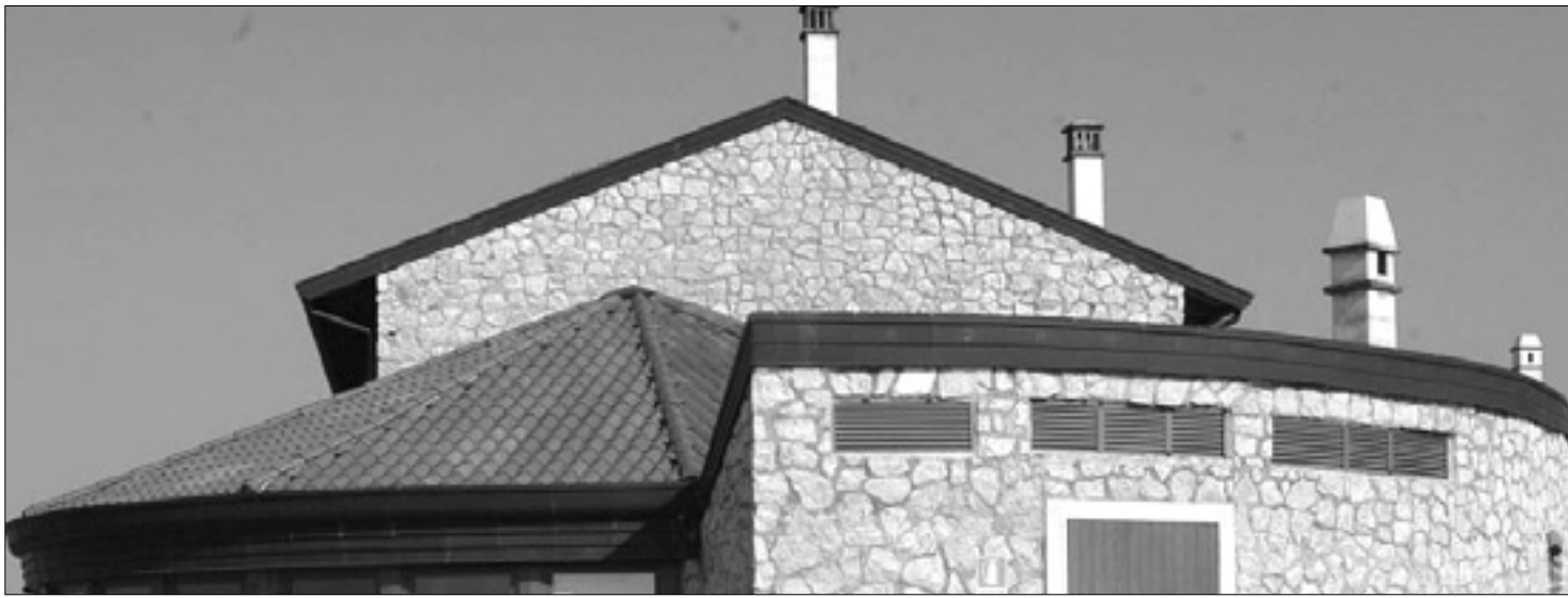
Sprejemni center Gradina bodo opremili s fotovoltaično napravo
