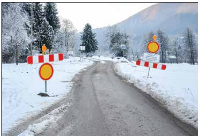
Odsek ceste Rečica ob Savinji - Vimpasle bo kmalu saniran.
