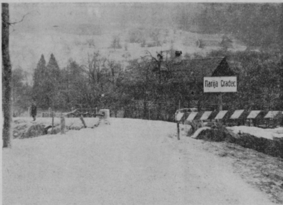
Tole je zavarovanje mostu čez Lahomnico pri znameniti cerkvi s freskami v Marijagradcu. Dve preklji in obarvana deska sta edini ograji, ki naj varujeta ljudi in vozila pred strmoglavljenjem v potok. Kadar zapade sneg je še huje, ker je tik za ovinkom oster ovinek. (Foto: J. Krašovec)
