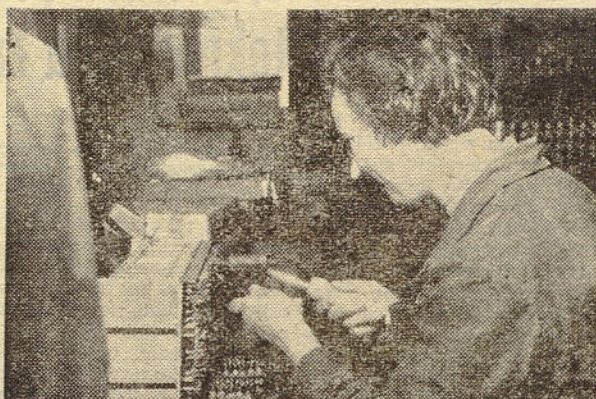
Tov. Rozi Tičar pri spajkanju impulznega oddajnika za telefonsko centralo
