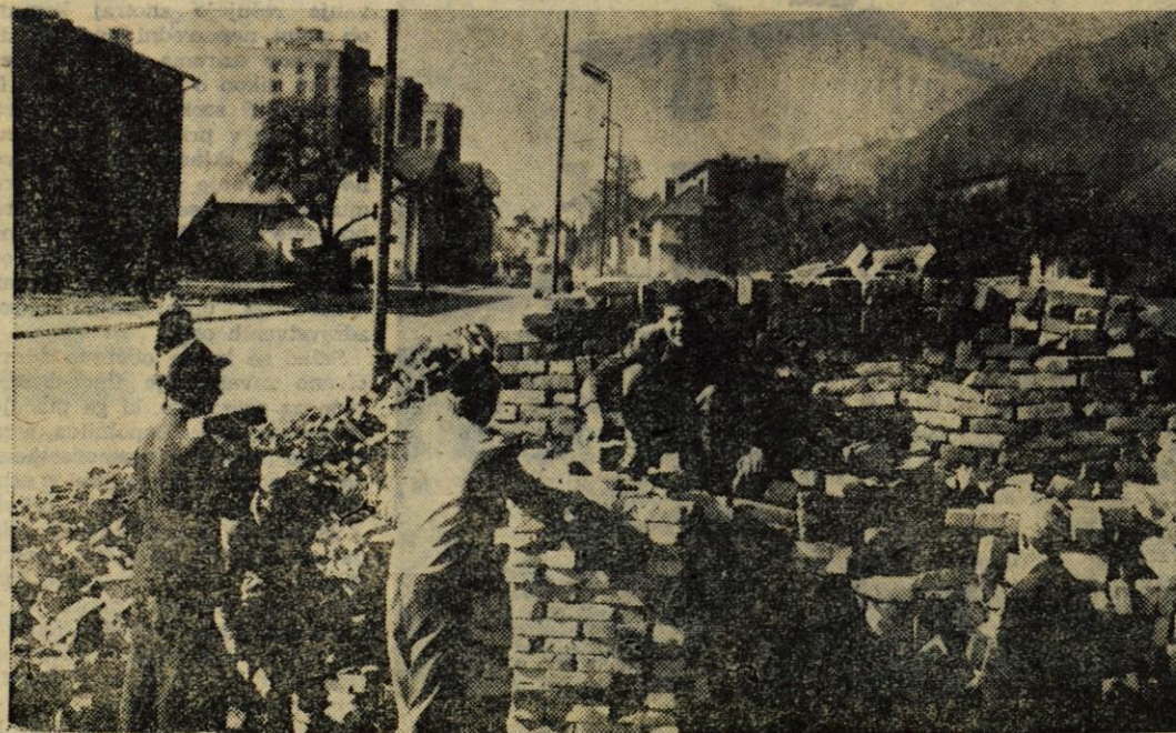
Prvi začetki gradnje novega zdravstvenega objekta na Jesenicah
