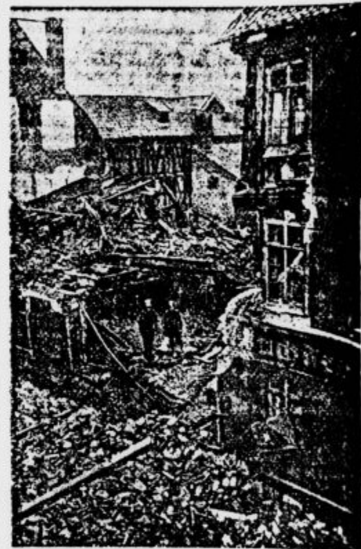
V vzhodnopruskem mestu Insterburg se je nenadoma sesula večnadstropna hiša. Ko so razkopavali ruševine in rešili dva ranjenca, pa je izbruhnil požar. Hiša se je sesula radi eksplozije posod z ogljikovim kisikom.
