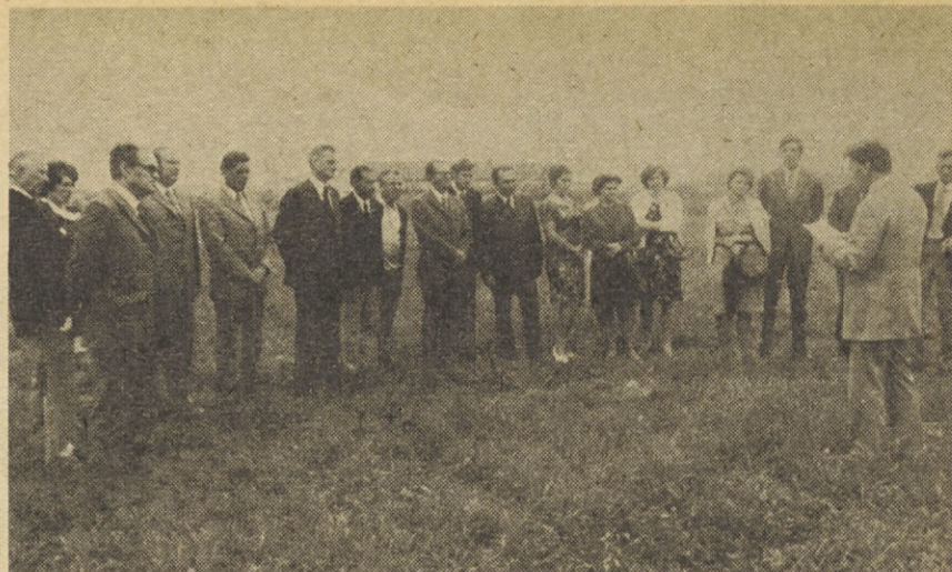
Gostje in člani kolektiva poslušajo besede novega direktorja TOZD »Žarnice« ob slavnostnem začetku gradnje nove tovarne avtomobilskih žarnic na Stegnah, kamor se bo delovni kolektiv iz pretesnih in neustreznih delovnih prostorov v Kotnikovi ulici — upajmo — zares ob letu dni, kot obetajo načrti in izvajalci del, preselil.
