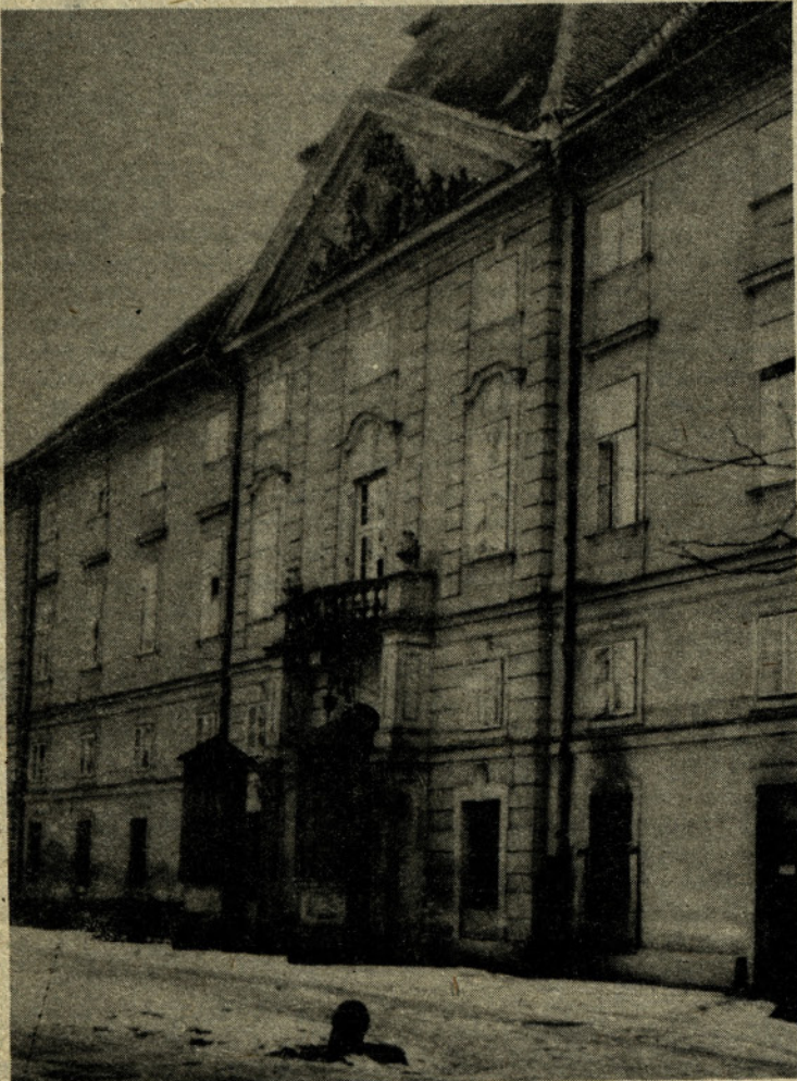
Odgovora na to, kakšna usoda čaka objekte v Novem Celju, še ni, čeprav objekte močno načenja zob časa. Na izvršnem
