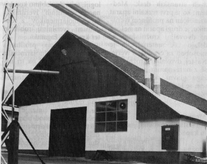
prenovljena vzdrževalna delavnica v TO Tomaž Godec
