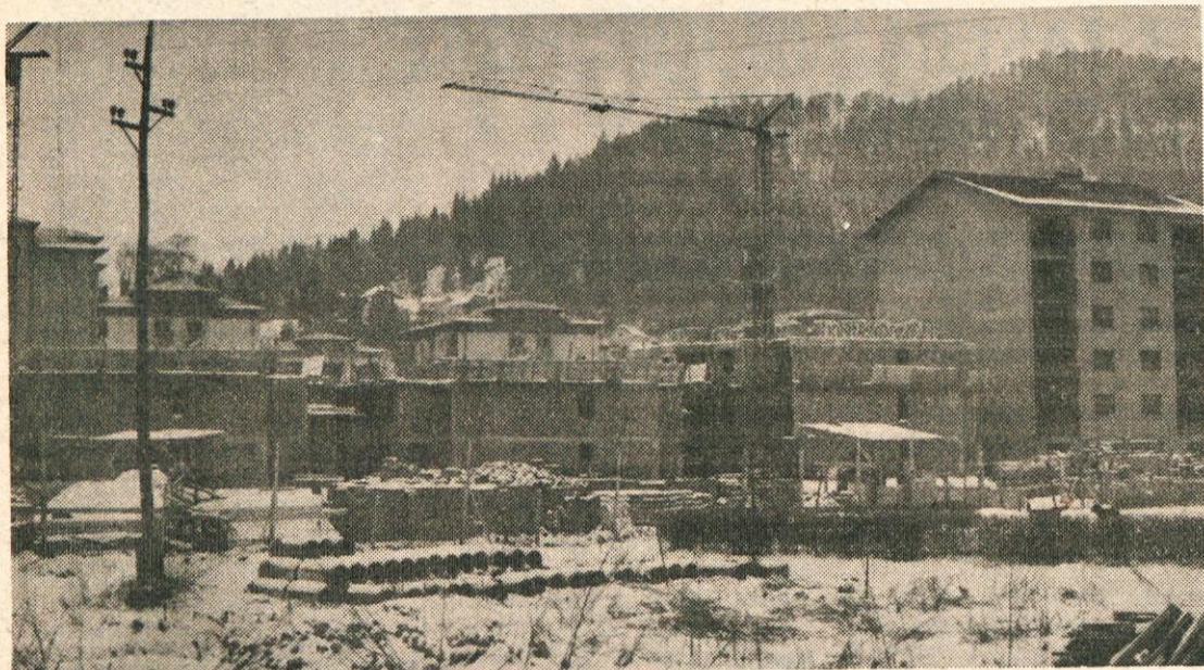
V Litiyi v KS desni breg gradimo med Zasavsko cesto in Cesto komandanta Staneta nove stanovanjske bloke (Foto: GO)
