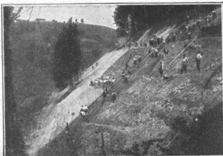
V HALOZAH GRADIJO NOVE CESTE. Gradnja novih cest da zdaj domačemu prebivalstvu vsaj nekaj zasluzka, ki se delno izplačuje v hrani. Prva slika kaže, kako napredujejo dela na cesti, ki bo vezala vinopodni Zavro s Turškimi vrhom in známim draviliškim krajem Klenovnikom v savski banovini. Na drugi sliki pa je pogled na okolje ceste, ki jo gradijo od Leskovca do Podlehnik.
