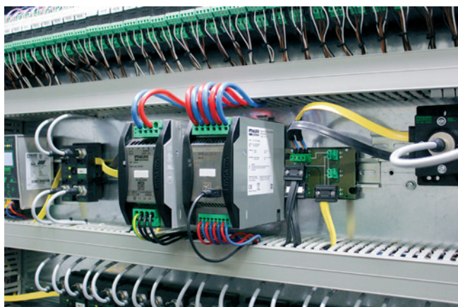
» Modul za neprekinjeno napajanje Emparro ACCUcontrol UPS proizvajalca Murrelektronik. Vir: Murrelektronik
