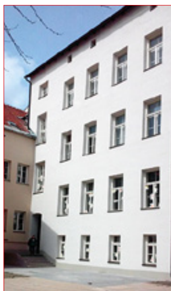
OŠ Olge Meglič po energetske sanaciji
