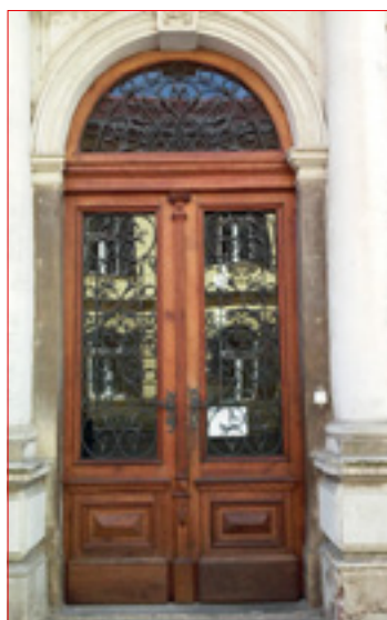
Obnovljena – restavrirana vhodna vrata na OŠ Olge Meglič
