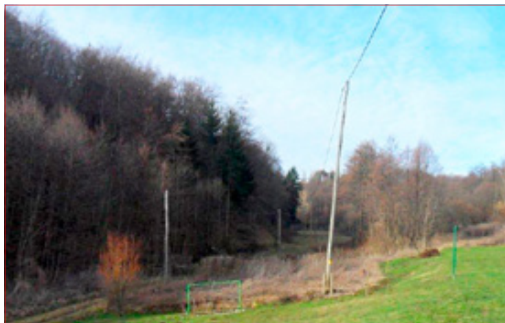
DV Grajena v Globoki grabi, kjer so vodnike zamenjali z univerzalnim kablom.
